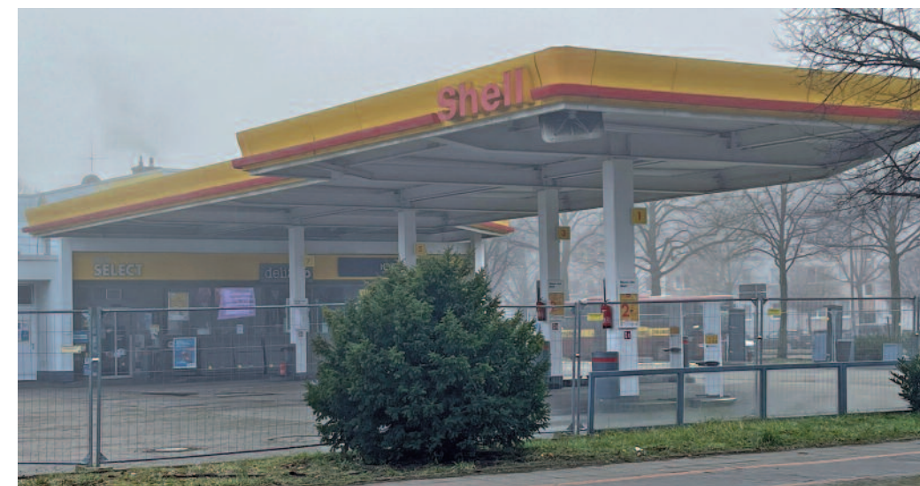
Die Tankstelle gegenüber dem Freizeitheim wird abgerissen.
